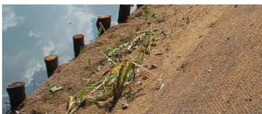
Sur les endroits où le courant est fort, la berge est protégée de l'érosion par une natte en tresses de coco, et les éclats sont plantés dans les interstices où ils sont protégés de l'arrachement dû à l'eau.
